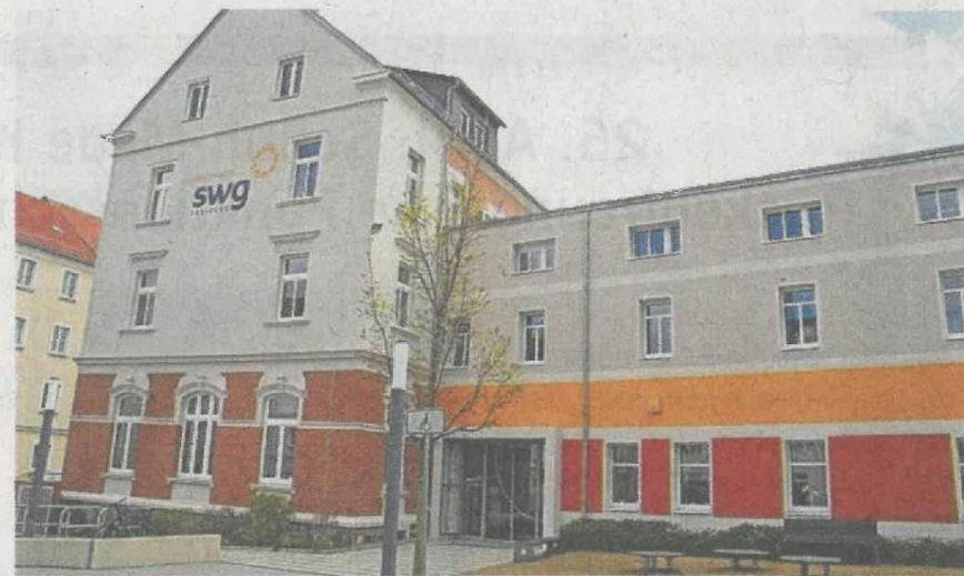
Bereits im vergangenen Jahr wurde die Fassade an der Beuststraße mit einem Wärmeverbundsystem erneuert und außerdem farblich ansprechend gestaltet.
